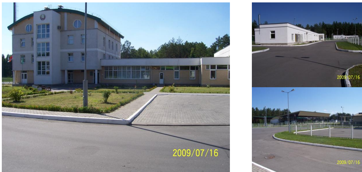
Рисунок 3 – Комплекс из 4-х зданий, отапливаемых теплонасосной геотермальной установкой на пограничном и таможенном переходе «Новая Рудня» на границе с Украиной.
