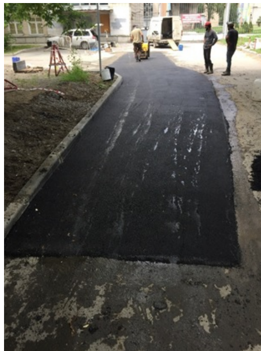
Благоустройство после ремонта трубопровода
