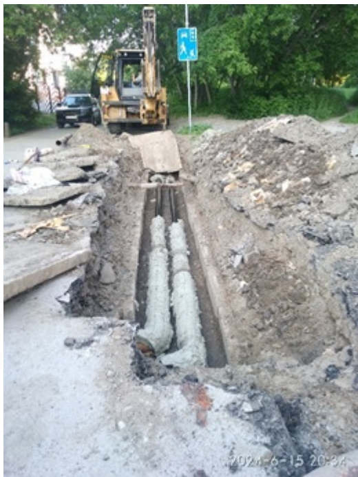
Трубопровод после ремонта
