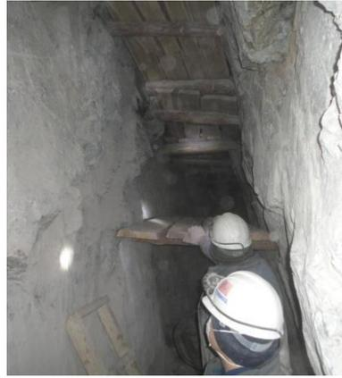
Рисунок 4. Рабочие и предохранительные полки из дерева
