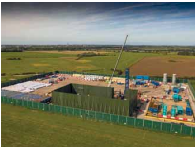
Рис. 5. Фотоснимок скважины на участке Preston New Road (Lancashire, England) [11].
