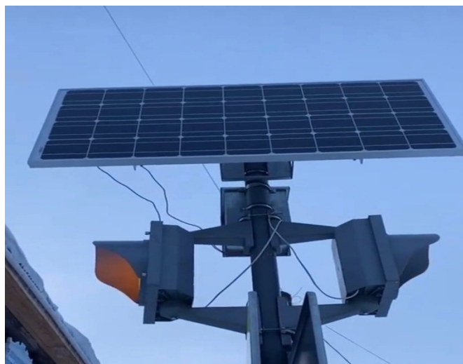
Рисунок 1- Использование фотоэлектрической станции в нерегулируемых пешеходных переходах [3]
