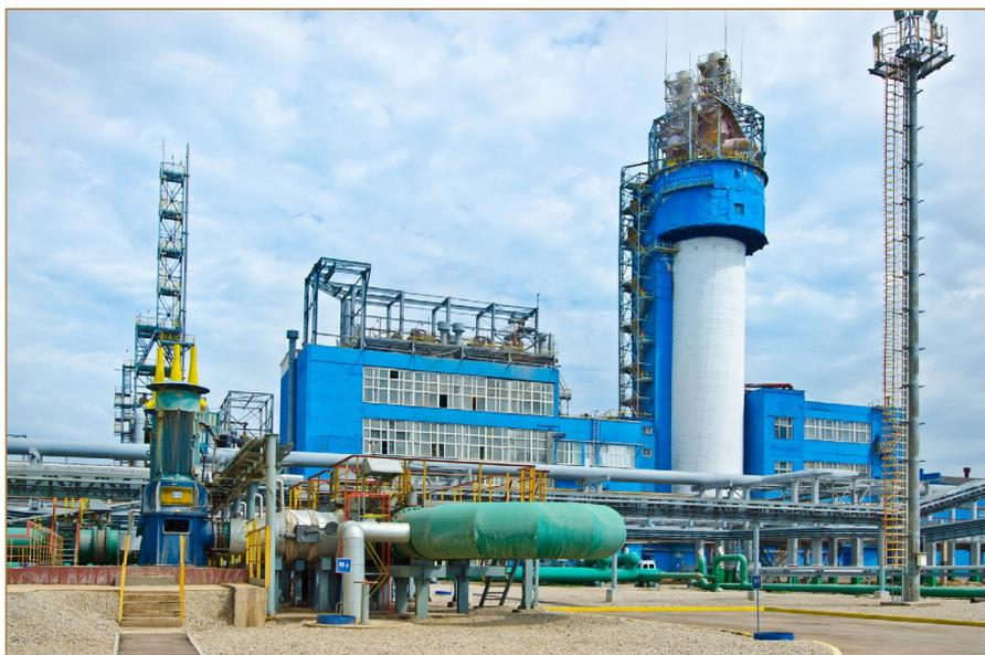
В Великом Новгороде в 2018 году введен в эксплуатацию новый агрегат по производству карбамида мощностью 600 тонн в сутки «Карбамид-600». Новое производство построено по технологии URECON®2006 (рис. 11). В настоящее время ПАО «Акрон» проводит модернизацию производства, что позволит увеличить
