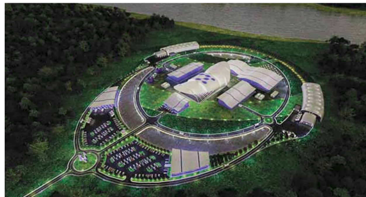
РИСУНОК 4. MMP консорциума RR электрической мощностью 400 МВт
