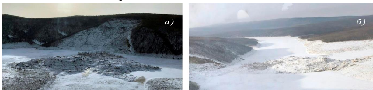
Рис. 1. Завал в Бурейском водохранилище, после схода оползня: а) вид с правого берега водохранилища (устье р. Средний Сандар); б) вид с верхнего бьефа завала
