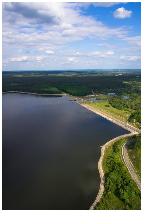
Рис. 2. Гидроузел Белгородского водохранилища
