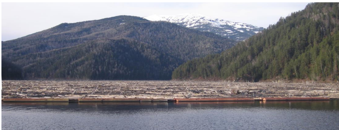
Рис. 3. Боновое ограждение запани, общий вид
