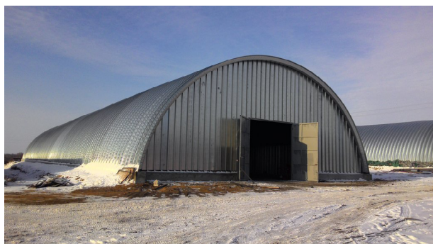
Рис. 2. Ангар металлический напольного хранения зерна
