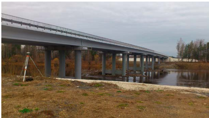
Рис. 6. Мостовой переход после реконструкции
