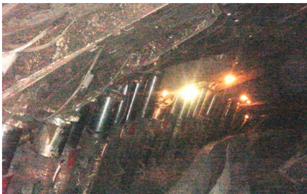
Рис. 4. Разворот поддерживающих элементов в традиционной секции крепи при смещении равнодействующей от опорного давления в сторону завала
