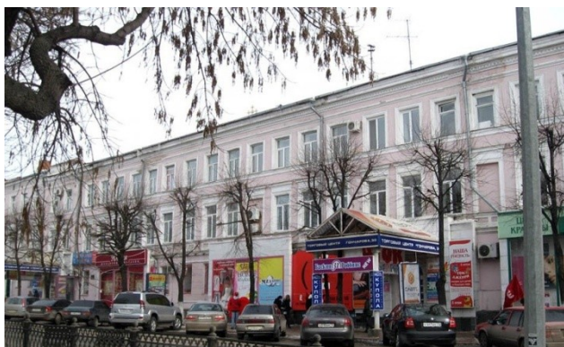
Рис. 2. Современное состояние здания бывшей Духовной семинарии. Фото К.Н. Ворковой
