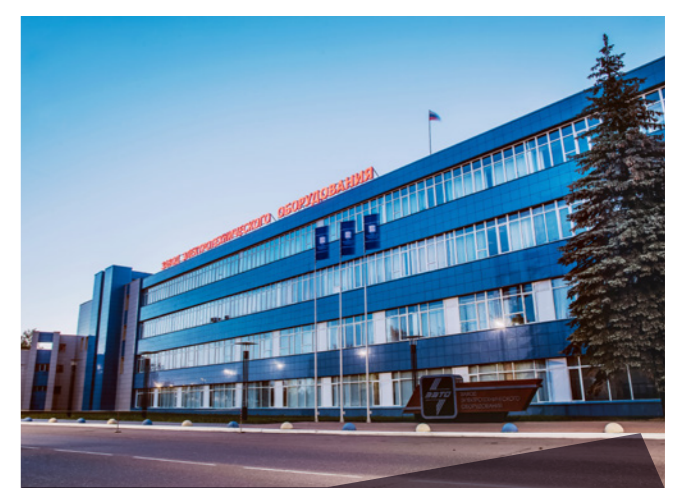
Промышленный технопарк "Электрополис"
