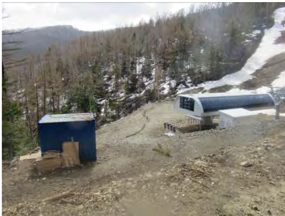
Рисунок 3. Трещины отседания антропогенного оползневой и потенциального селевого массива на трассе «Север».
