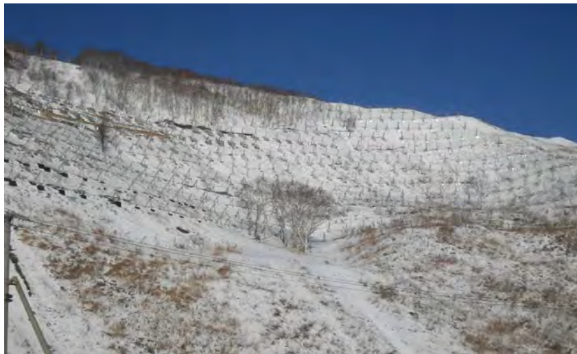
Рисунок 3. Снегоудерживающие заборы на 219 км ПК2 линии Корсаков-Ноглики.
