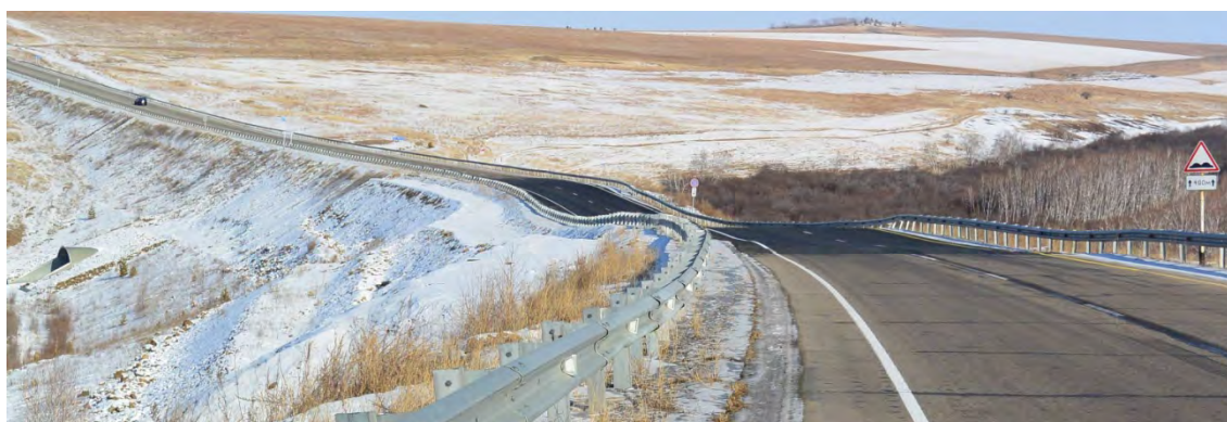
Рисунок 2. Деформации автодороги «Амур» Чита – Хабаровск, 247 км, март 2015 г.
