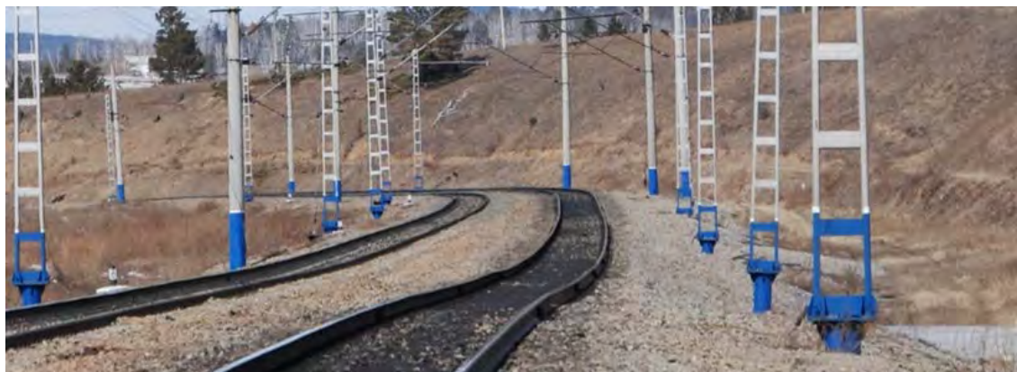
Рисунок 1. Деформации пути Забайкальской жд., 6278 км, март 2013 г.
