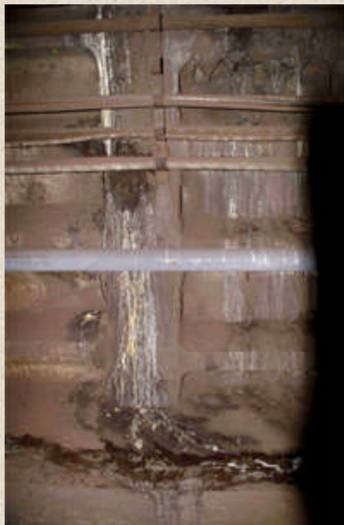
Высачивание воды из вертикального шва между тубингами, начальная фаза образования натечных форм
