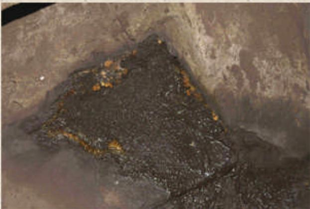
Высачивание воды, увлажнение поверхности обделки с высолами и образование ржавчины
