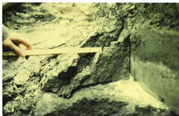
Рис. 12. Расслоение [6] и ориентация сердцевины уплотненного блока
