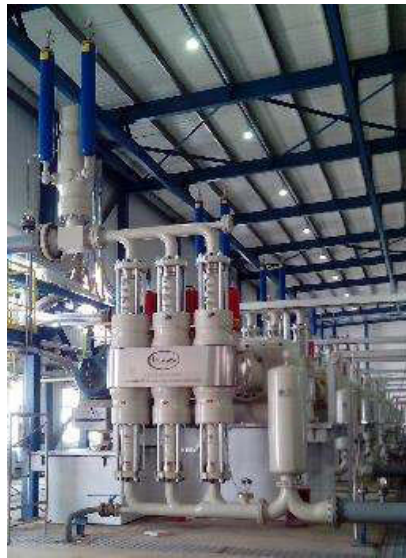
Рис. 1. Семицилиндровая конфигурация двухшланговых мембранных насосов
