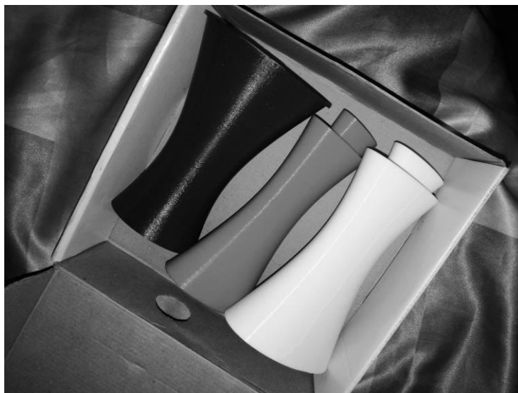
Рис.2. Изготовленные неразбирающиеся конструкции-опалубки
