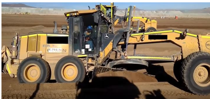
Рис. 2. Выполнение автогрейдером работ по устройству земляного откоса
