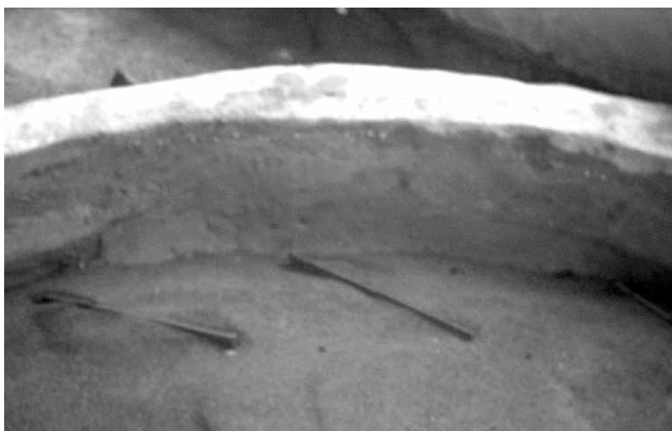
Рис. 3. Почти идеальная стабилизация участка резкого поворота русла, у вогнутого берега с помощью косорасположенных донных порогов малой высоты. Направление транзитных струй – справа налево
