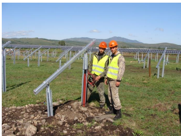
Фото 4. Выполнение электромонтажных работ
