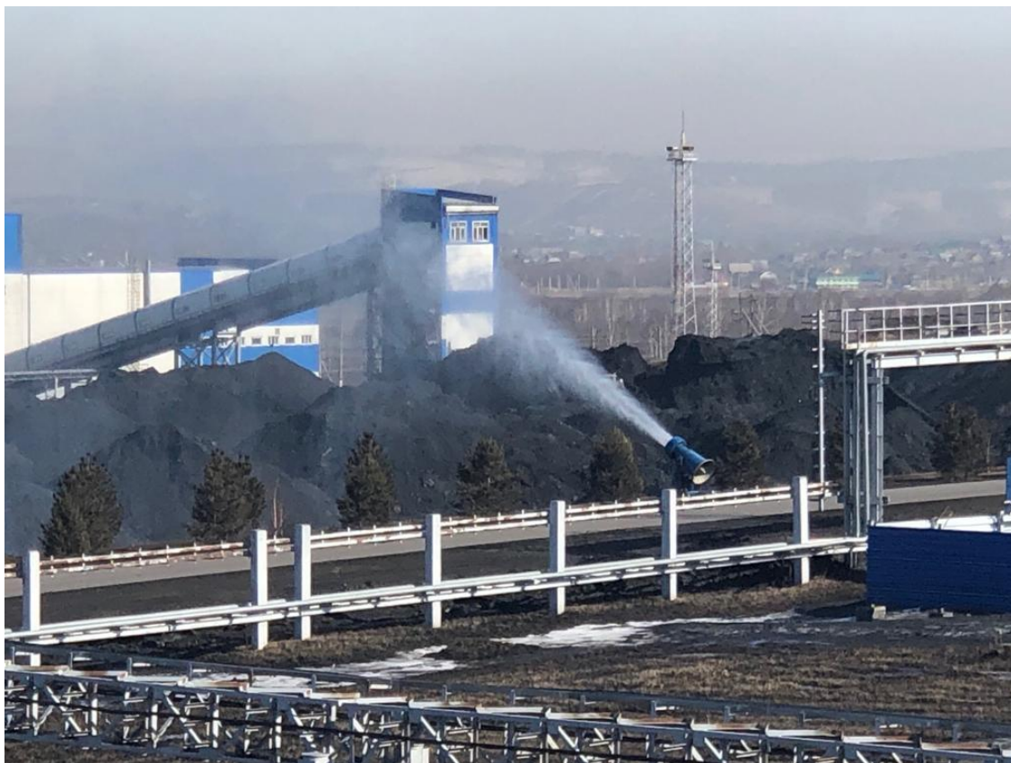
Рисунок 2 – Использование снегогенератора на разрезе «Березовский»
