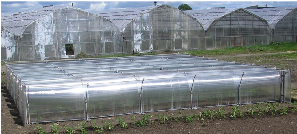
Рис. 6. – Технологический модуль защитных конструкций экранного типа в ЗАО «Приобское» Новосибирской области (2016 г.)
