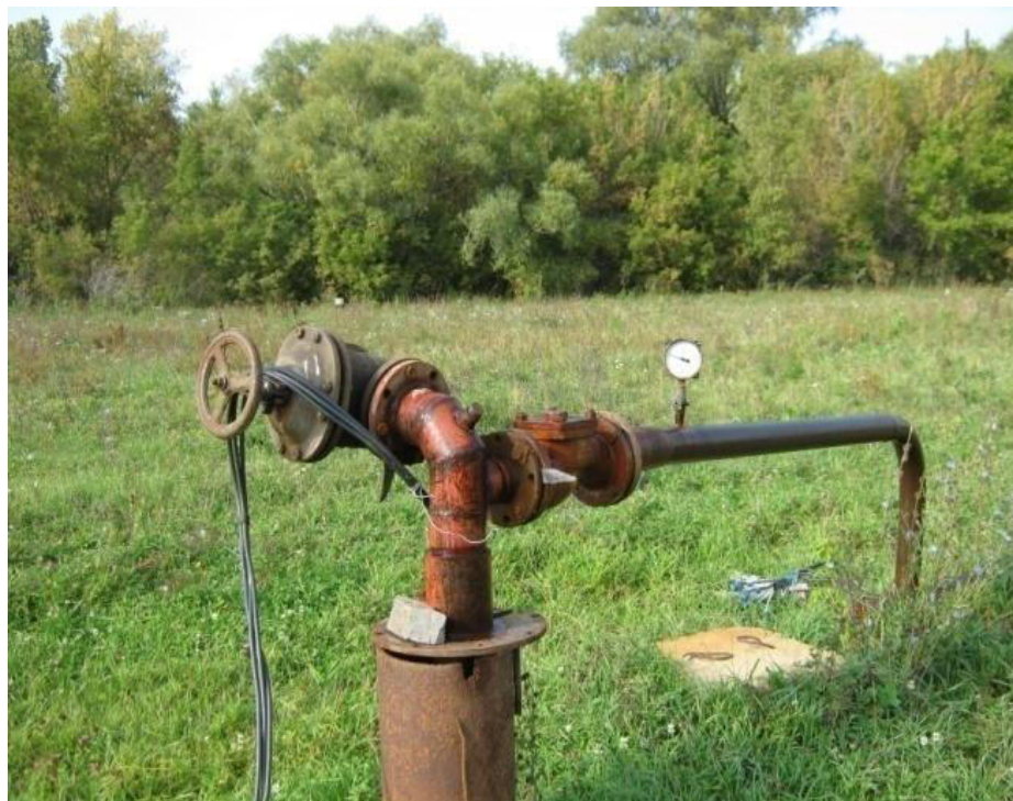
Рисунок 1. Оголовок водозаборной скважины в Чарышском районе
