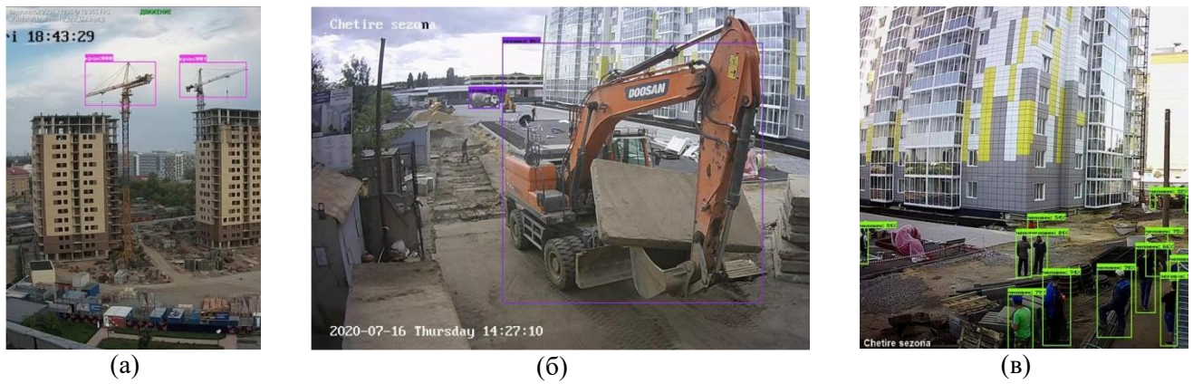
Рисунок 1 – Примеры изображений детектированных объектов разных классов: а – башенный кран; б – строительная мобильная техника; в – человек.
