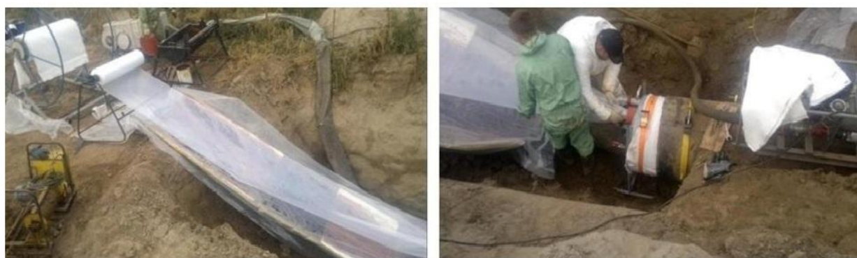
Рисунок 4 – Ввод полиэтиленового рукава с выворотом под давлением воздуха внутрь пропитанного клеем тканевого рукава, предварительно протянутого в трубопровод
