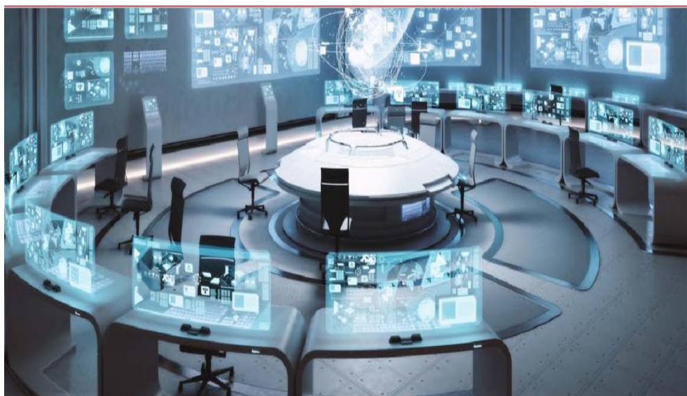
Рисунок 1 – Вид центрального пульта управления Control Tower 1
