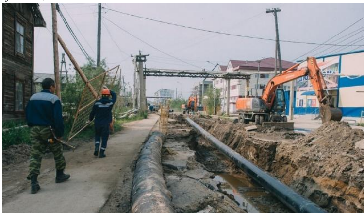
Рис. 1. Вскрытие дорожного полотна для замены устаревшего газопровода по улице Чайковского, г. Якутск
