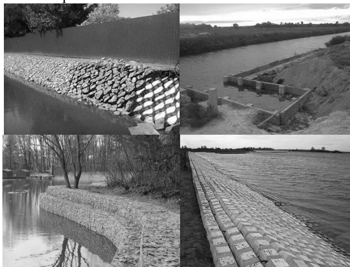
Рис. 4. Примеры укрепления берегов
