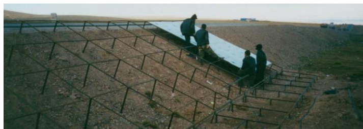
Рис. 2. Сооружение солнцезащитного навеса на Цинхай-Тибетском шоссе, сентябрь 2003 г
