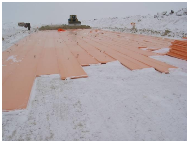
Рис.1 Укладка теплоизоляционного слоя из пенополистирольных плит «Пеноплекс», ЯНАО
