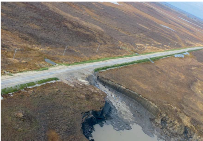
Рис. 1. Термоэрозия грунтов и образование оползней - сплывов из-за вытаивания пластового льда вблизи подъездной автодороги (аэрофотоснимок)
