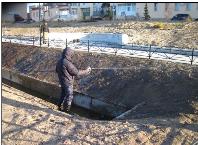
Рис.3. Закрепление откосов с помощью криогелеобразующего раствора
