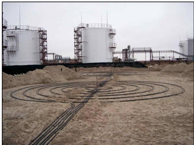
Рис.7. Горизонтальные охлаждающие элементы в основание емкостей резервуарного парка (фото "Фундаментстройаркос")
