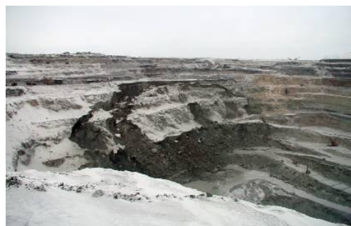
Рис.1. Обрушенный участок борта карьера в мерзлых породах
