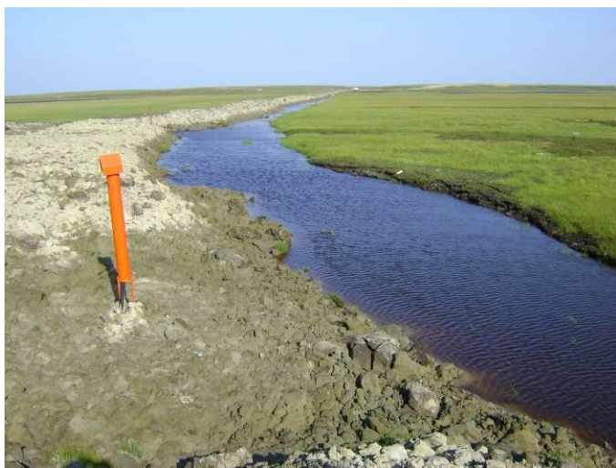
Рис.1. Формирование протяжённого техногенного термокарстового озера в результате подтопления территории обваловкой подземного трубопровода. На переднем плане стойка измерительного блока системы ведомственного технологического геокриологического мониторинга
